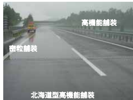
写真 4 舗装の違いによる路面の反射状況
