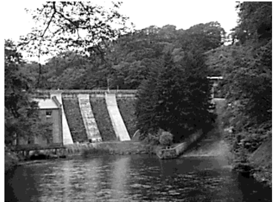
写真1 王子製紙千歳川第4発電所
