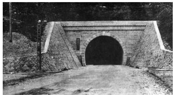
写真-9 竣工当時の張碓隧道（道路工事報告書より抜粋）
