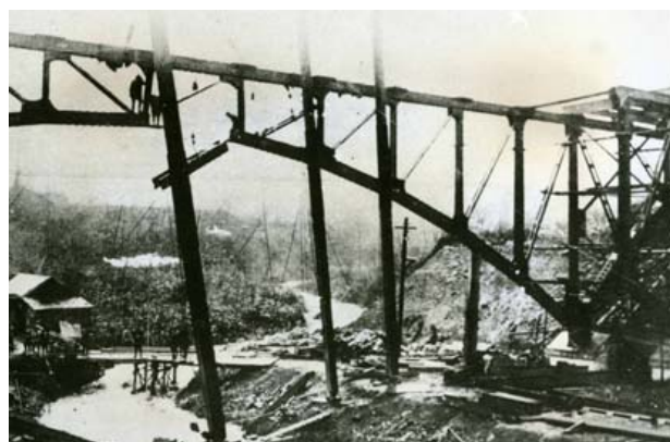
写真－4 上部構造の架設状況（道路工事報告書より抜粋）
