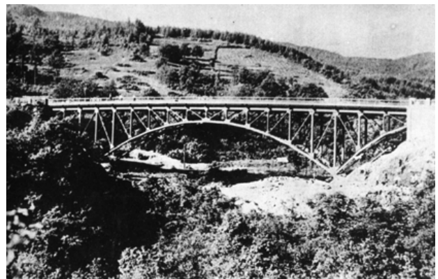
写真－3 竣工当時の張碓橋（道路工事報告書より抜粋）
