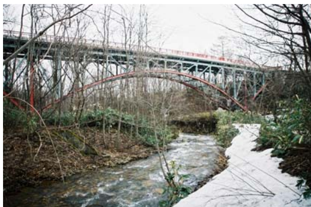
写真-1 張碓橋の現況写真（撮影：進藤 義郎）
