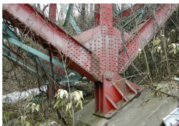
写真－5 橋脚支承部の状況（撮影：進藤 義郎）
