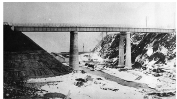
写真-8 竣工当時の朝里橋（道路工事報告書より抜粋）
