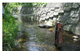
(a)水位計設置状況
