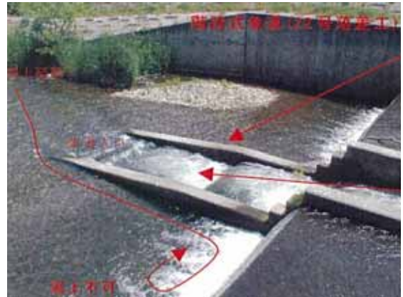
図-1 厚別川第22号落差工魚道(平成4年度新設) 2)
