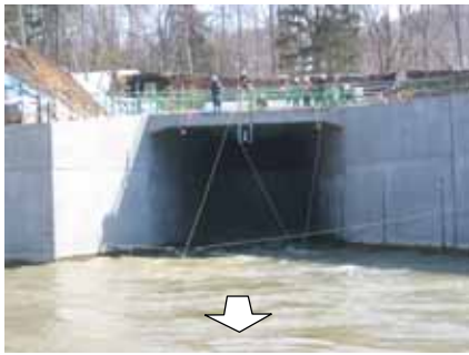
写真-1 開口部末端(aライン)流速の計測状況
