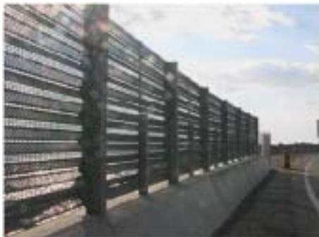
図-1 道路護岸上に設置された防波フェンス
