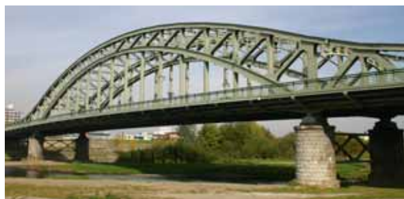
写真-1 旭橋の現況写真
