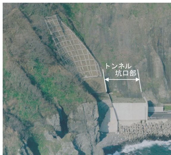
写真-1 トンネル坑口部の例
