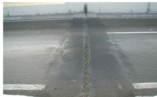
写真-4 実橋設置状況
