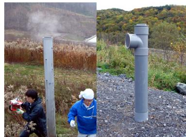
図-1 埋立終了前後に設置されたガス抜き管(左)と平成17年に設置されたガス抜き管(右)
