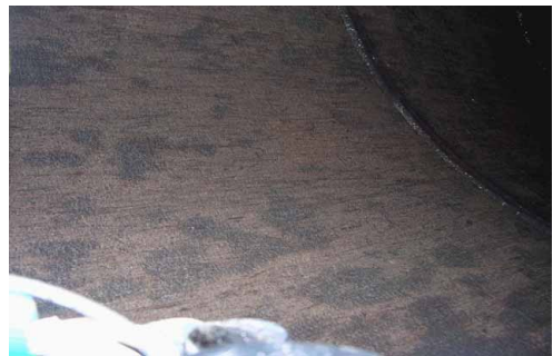
写真－12 水圧鉄管内面（左側）
