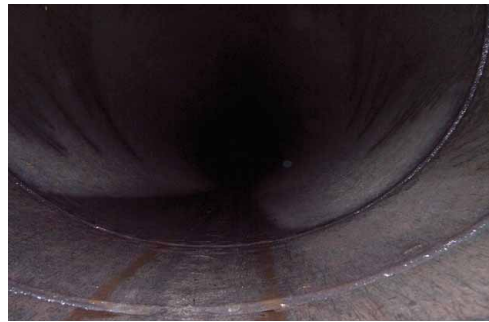
写真－11 水圧鉄管内面（正面）
