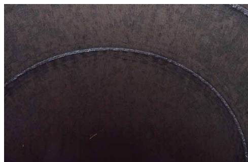
写真－14 水圧鉄管内面（上部）
