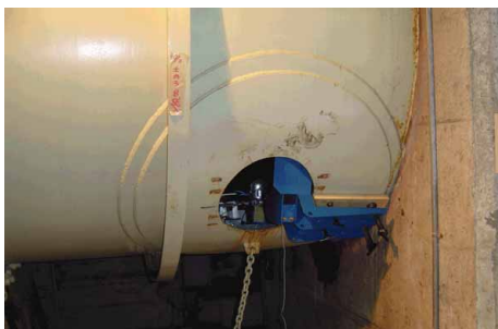
写真－10 マンホール
