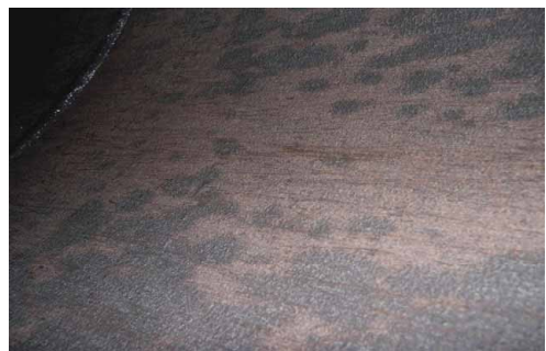
写真－13 水圧鉄管内面（右側）
