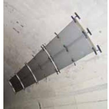
写真-4 漏水防止板設置状況 (4枚×上下2列8m)
