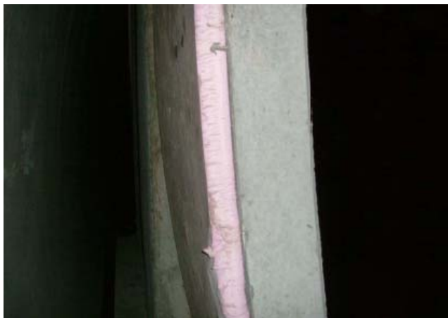
写真.3 断熱材 (PE フォーム)
