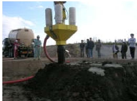
写真-2 新工法による散布状態(女満別)
