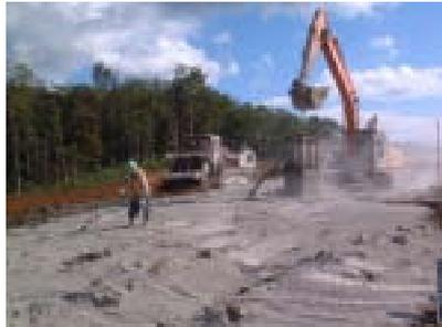
(b)人力による固化材の混合
