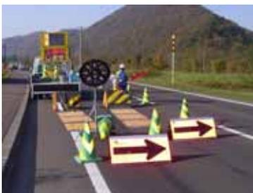
写真 - 1. 路上作業エリアの一例
