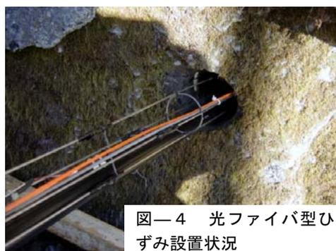
図-4 光ファイバ型ひずみ設置状況
