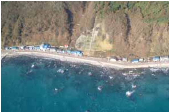
写真-3 赤石地区の状況
