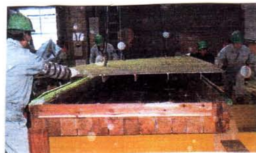
写真-1 木スラブとリブつき鋼板の工場接着
