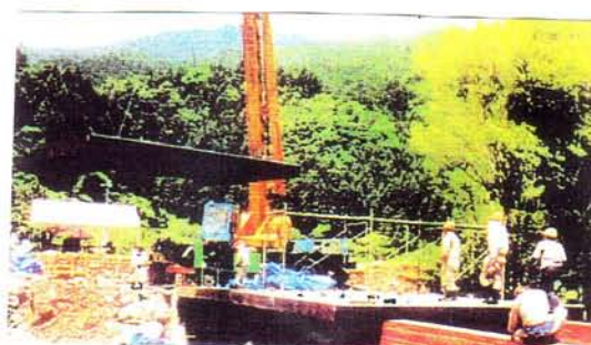
写真-4 鋼床版の落とし込み現場接着
