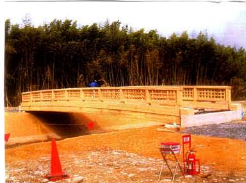
写真-2 「国営公園北派川橋」の完成
