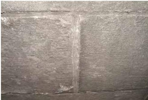
写真-3 輪石の合口に挿入されたモルタル
