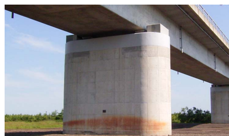
写真－1 P-2 橋脚の現況写真（起点側より撮影）
