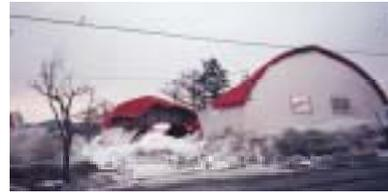
写真1 2004年1月北見地方の大雪の荷重で崩壊した農業用倉庫(佐呂間町栄国道333号沿い)
