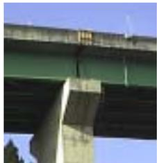
写真 24 桁間の上部地震時の衝突によるコンクリート一部破損したのみでほとんど損傷は確認されなかった。
