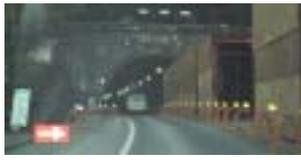
写真 20,21 和南津トンネル内補強支保工補修状況 10日以内の早期に応急復旧し災害復旧や首都圏からの支援ルート確保, 和南津トンネルの復旧作業時用保護工枠
