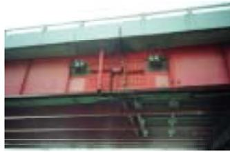
写真 18,19 鋼主桁端部損傷（長年供用のため腐食の影響もあるか）阪神淡路大震災以降の耐震対策として設けられた落橋防止装置が効果を果たした。
