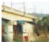
写真 15 樹林間の青シートの部分補修中でラーメン高架部がせん断破壊と報告された.
