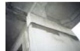
写真 26,27 同上現場（西側より撮影）の東大新江橋梁の RC 橋脚上部の橋台部直下裏側コンクリート剥離(左) 中央:剥落部をはつり落とす, はつり部にコンクリートを吹き付ける (2004年11月7日~8日)。
