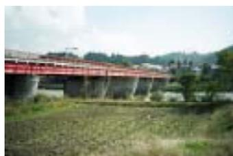
写真 17 国道 17 号線と南津橋梁 (1954 年施工) 鋼主桁端部破損, 橋脚の一部にひびわれ補修したが, 交通の通行は早急に確保されてる.
