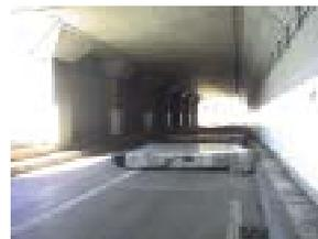
写真2 台風18号による、国道229号線神恵内(大森大橋)付近覆道コンクリート壁が強い波力等で倒れる。
