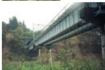
写真 16 JR 上越線のプレートガーダー橋枕木を留めているボルトが落ちていた箇所があったがほぼ健全
