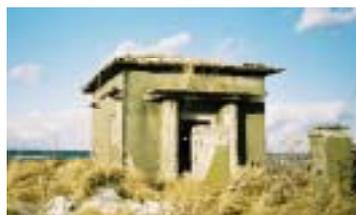
写真 37 旧通信省北方領土通信施設，建設後約100年経過しているが仕上げモルタルが，一部剥がれていたが，構造的には梁や内部隔壁があるためひびわれ等の発生等の被害は無かった
