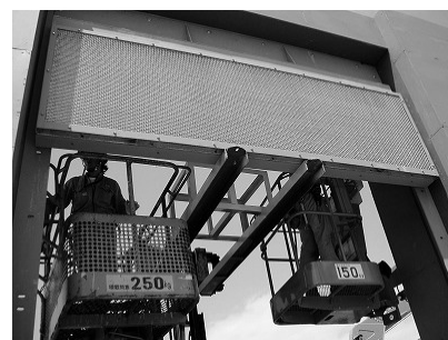
写真-5 施工実験状況
