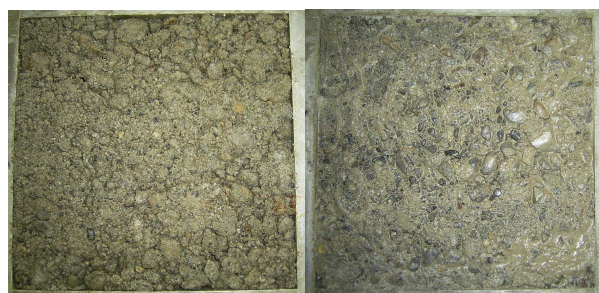
写真 - 4 粒状材路盤の表面状況 （左が載荷前 右が載荷後）
