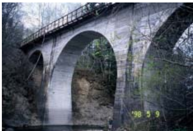
写真 2.3 糠平川橋梁 (写真大開コンサルタント(株)提供)
