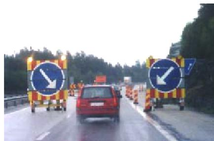
写真-4. ストロボ付き大型ゲート
