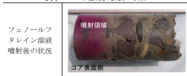
写真-4 中性化試験後の状況
