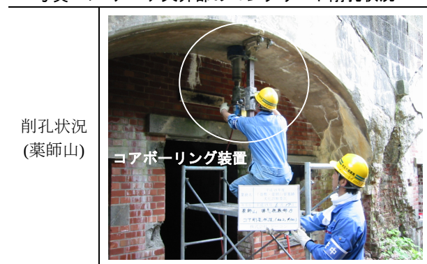
写真－1 アーチ天井部のコンクリート削孔状況
