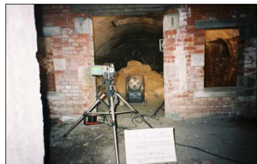
写真－7 赤外線カメラの設置状況
