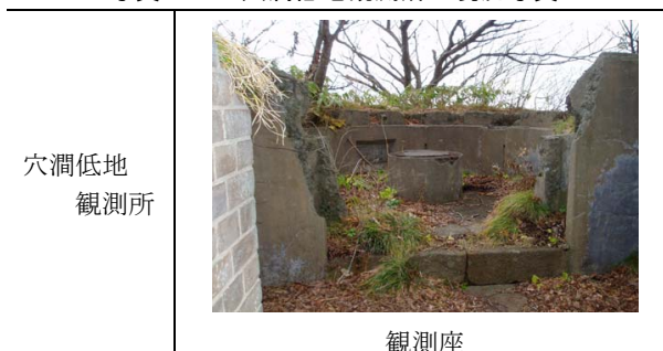
写真－8 穴澗低地観測所の現況写真
