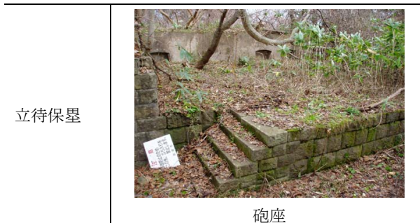
写真－7 立待保塁の現況写真
