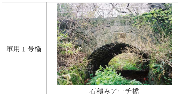
写真－9 軍用 1 号橋の現況写真
