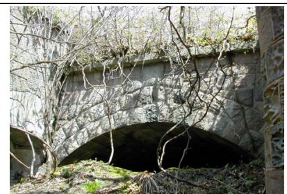
石積みアーチトンネル
