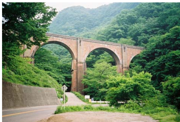
写真-2 碓氷第三橋梁【呼称：めがね橋】
