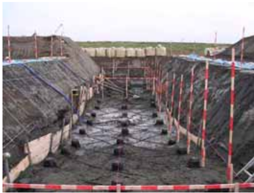
写真-3 開削底面に確認されたパイルネット工
