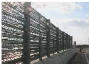
図-1 防波フェンス
