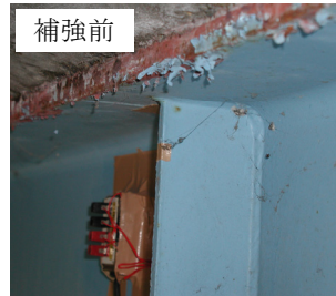
写真-4 予防保全を目的とした補剛材の補強
