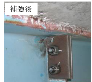
写真-4 予防保全を目的とした補剛材の補強
