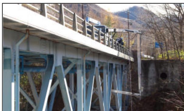
写真-6 簡易型橋梁点検車による点検
