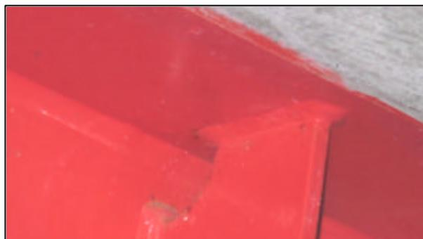
写真-7 上フランジ下面の垂直補剛材との溶接部
