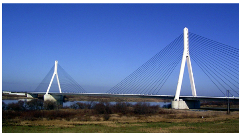
写真-1 美原大橋の全景
