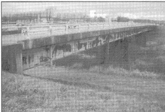
図-2 撮影対象橋梁の全景
