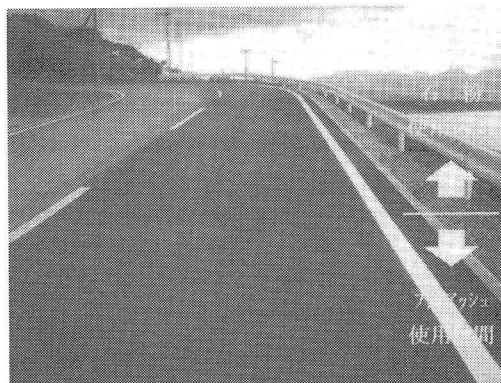
写真-3 舗設後の路面性状
