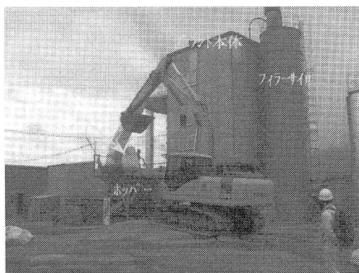
写真-2 フライアッシュ供給状況
