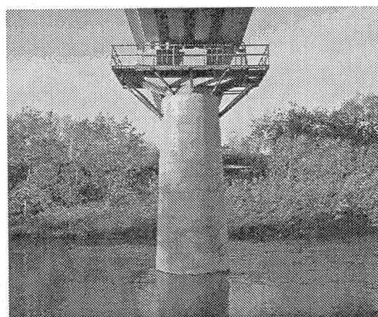
写真-3 復旧完了状況
