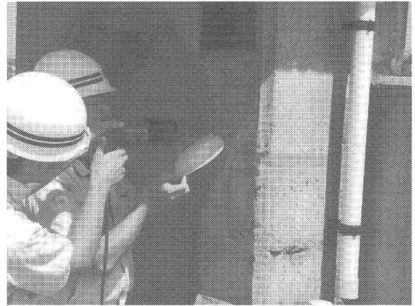
写真-1 ドリルによるコンクリート削孔粉採取状況
