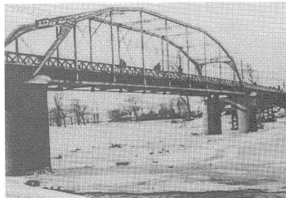
写真-2 初代旭橋
