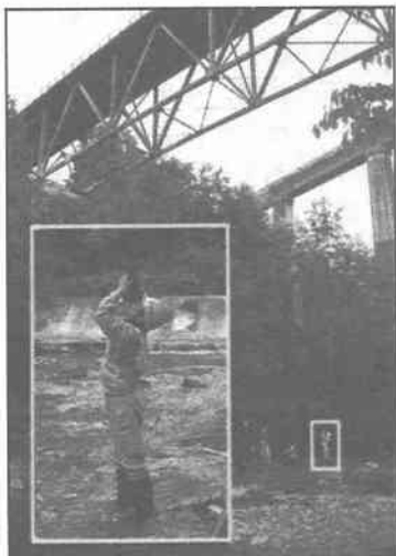
写真-1 本手法による 点検風景
