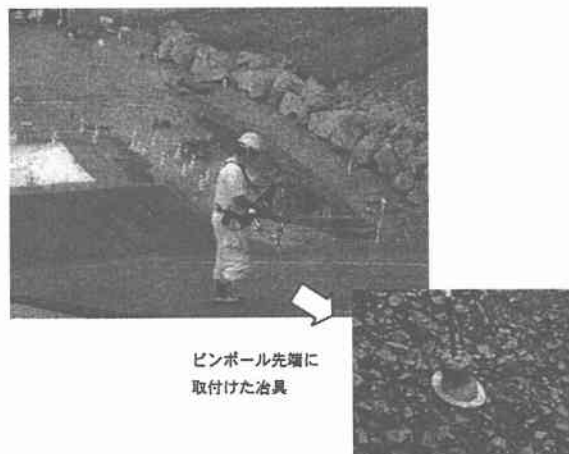
写真-4 3D-NAViでの斜面部舗装高さ測定状況
