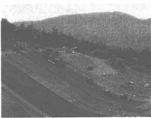
写真-2 斜面部舗設試験全景
