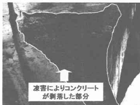
写真 3.1.4 凍害断面欠損状況(第六音更川橋梁)
