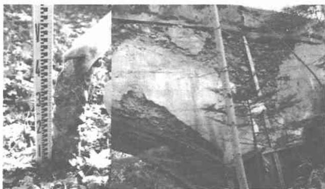
写真 3.1.4 凍害断面欠損状況(第六音更川橋梁)
