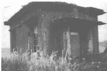
写真 3.1.7 根室旧北方領土通信施設
