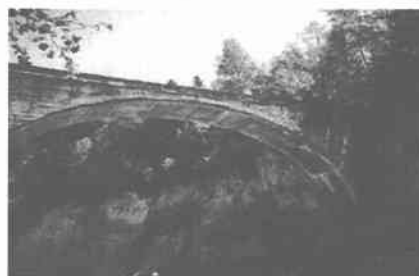
写真 3.1.1 第六音更川橋梁主スパン
