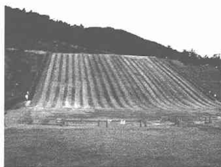
写真-1 斜面部舗設試験ヤードの全景
