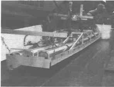
写真-3 ジョイントヒーターによる加熱
