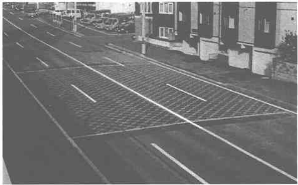
図-7 施工終了後の弾性ILブロック舗装
