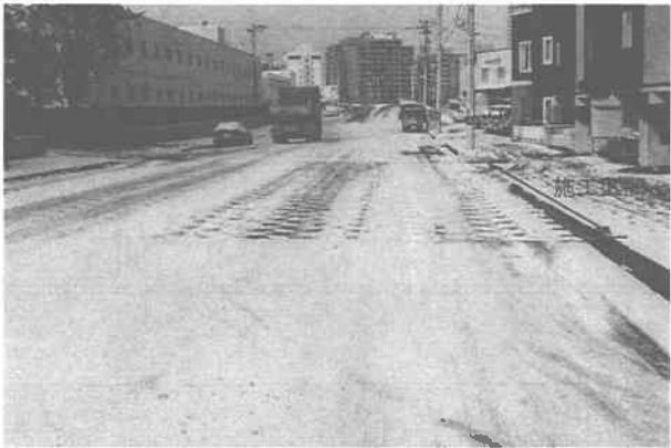
図-9 降雪後の路面状況（11月14日午前9時）
