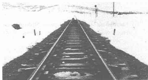
図1 挟み木挿入後の軌道(札幌線) 1)
