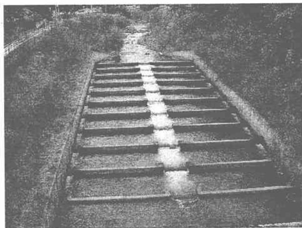
図-1 真駒内川第5・6号落差工
