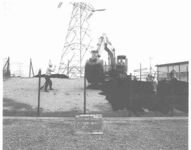
写真-3 マルチング材（木材チップ）敷設状況
