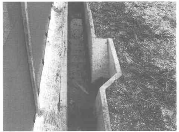
写真-2 自然環境保護型コンクリート製排水路
