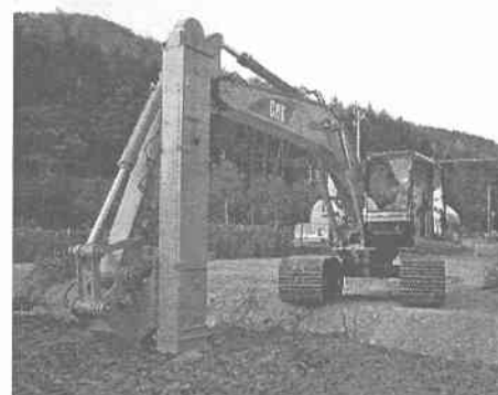
写真-2 実機試験状況
