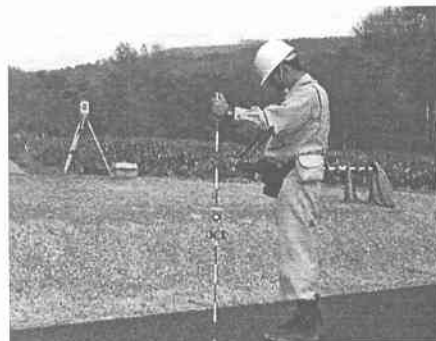
写真－1 3D-NAViによる測定状況
